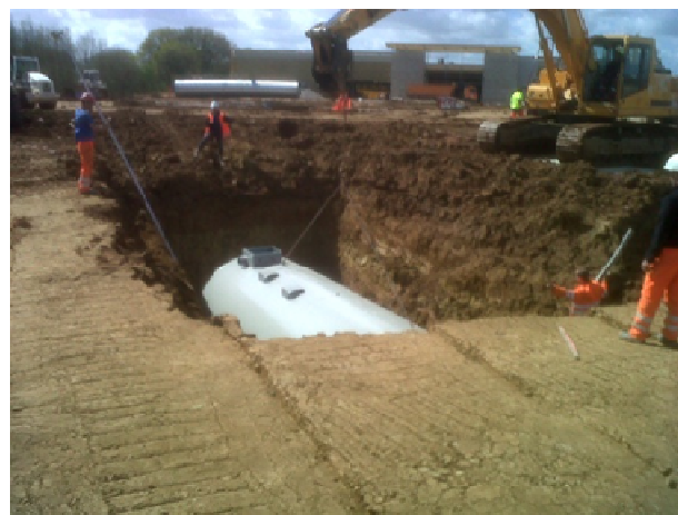
Vue de la cuve pendant la pose
