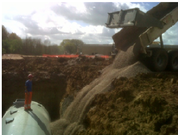
Vue de la cuve pendant la pose
