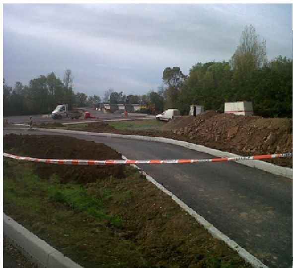
Vue du chantier
