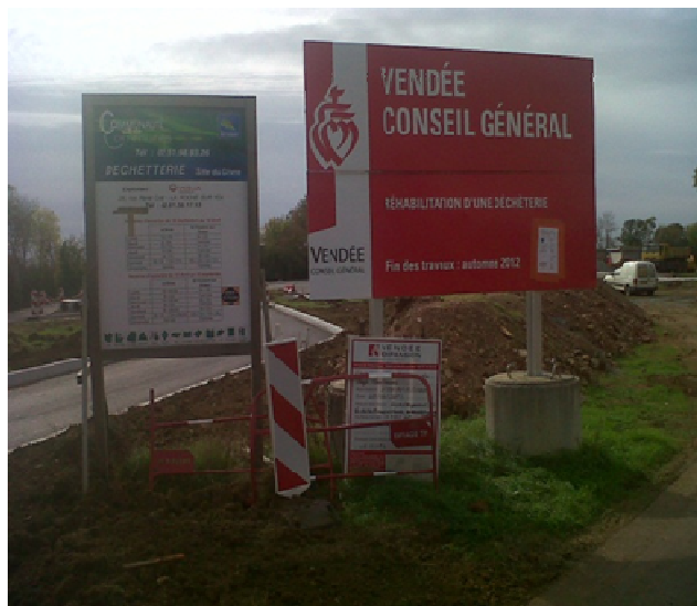
Vue du chantier
