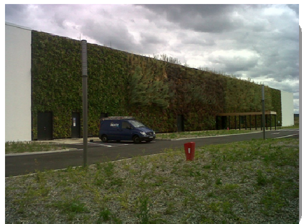
Vue DATA CENTER
