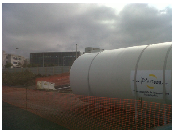
Vue cuve avant pose
