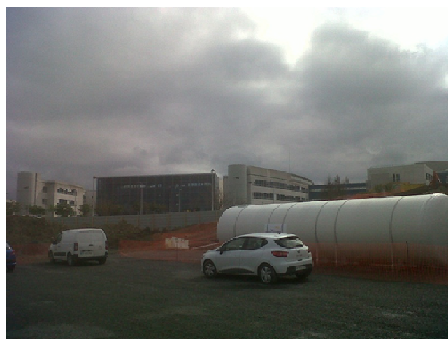
Vue cuve avant pose
