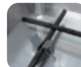
Surélévation du treillis pour faciliter sa prise dans le béton
