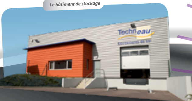
Le bâtiment de stockage
